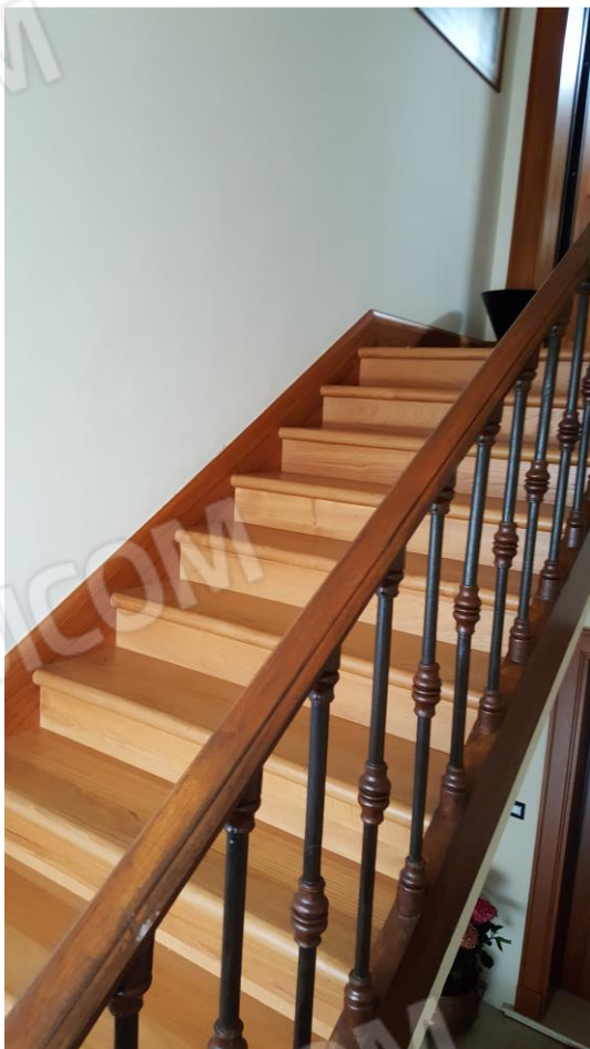
SCALA CONDOMINIALE DA 2° P. a 3° P.
